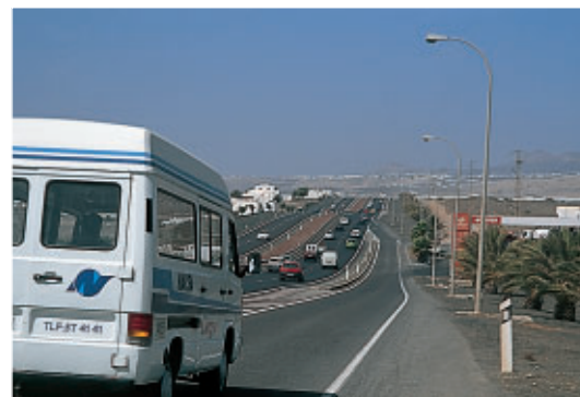
Autovía del Aeropuerto de Lanzarote. 2000
