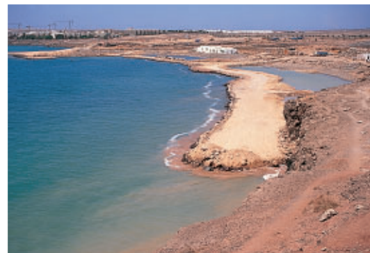
Rellenos para construir un muelle deportivo. El Berrugo. Playa Blanca. 2000
