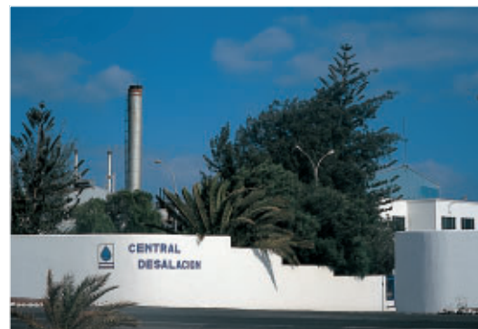
Desalinizadora de agua. Arrecife. 2000
