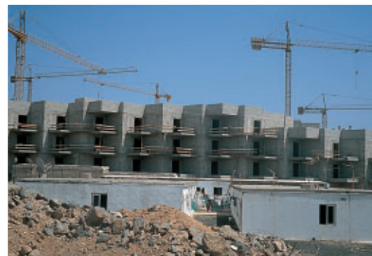
Construcción de plazas alojativas turísticas. Playa Blanca. 2000
