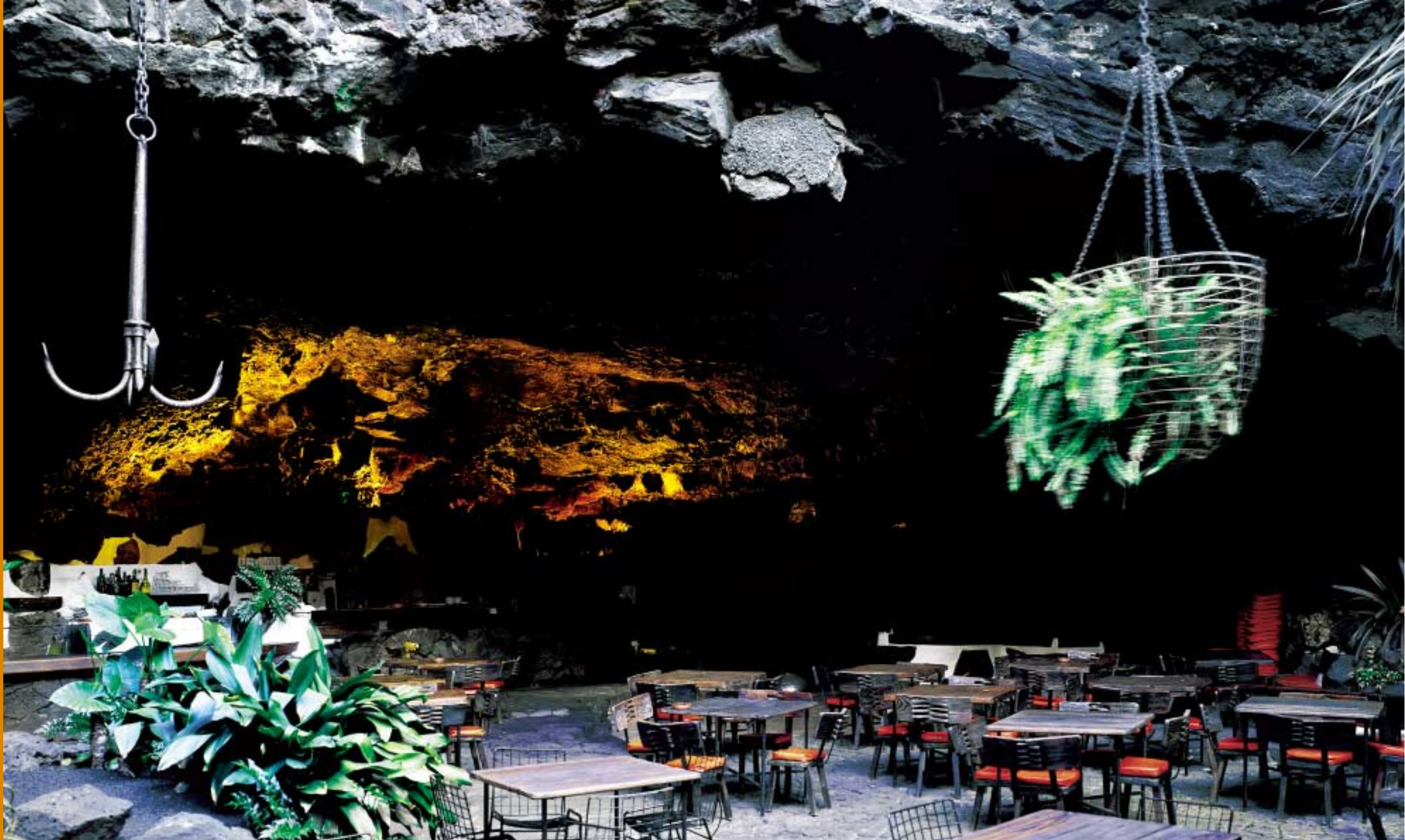
Jameos del Agua. Jameo Chico. Vista general de la cafetería
